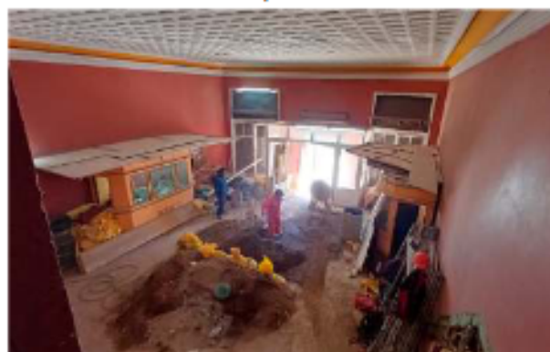
Trabajos en el interior del Palais Concert / cortésia
