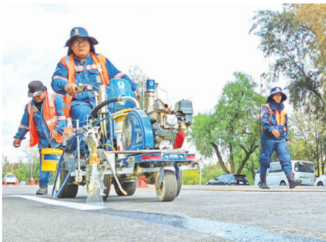
Trabajos en vías, señalización e iluminación.
