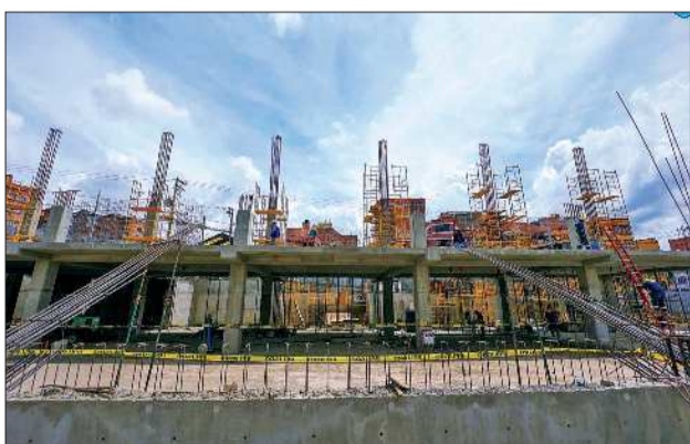
PILARES. Hormigón, pilares, losas y toda la construcción.
