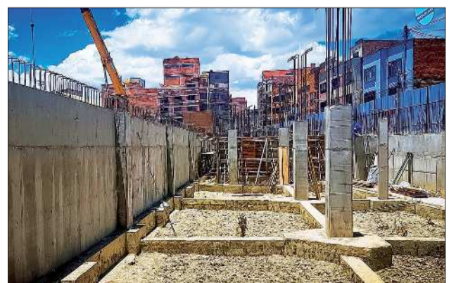
ZAPATAS. Los pilares emergen para sostener las tribunas.
