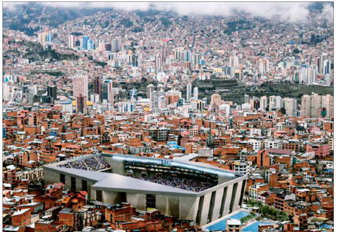
FORTALEZA. Bolívar tendrá su propio estadio, que está en plena construcción. Uno de primer mundo.
