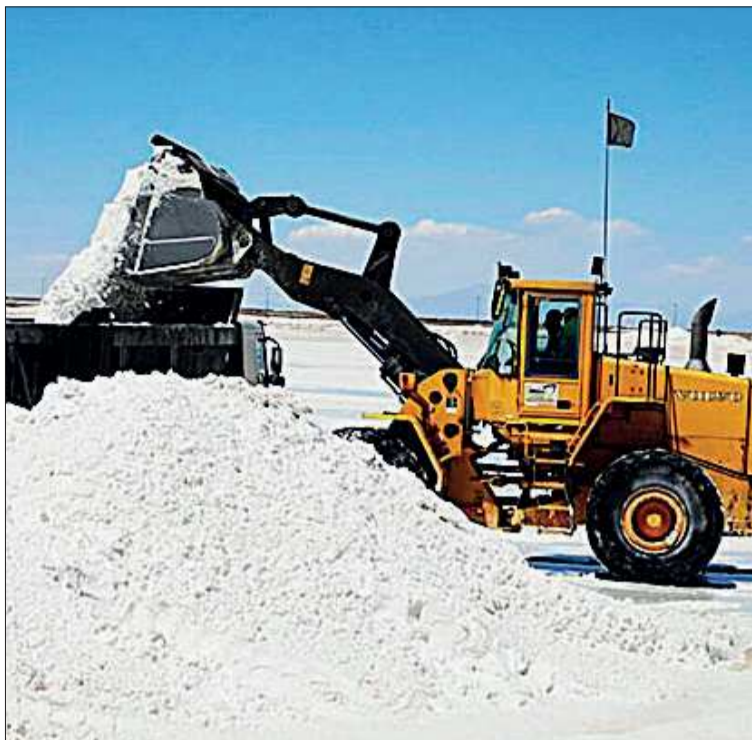
PROCESO Trabajos en salar de Uyuni, para la extracción de salmuera.
