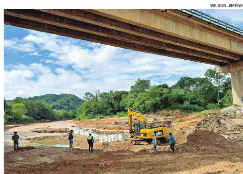
Los trabajos se concentran entre La Angostura y Samaipata.
