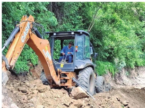
Maquinaria del Servicio de Caminos en pleno arreglo de vías
