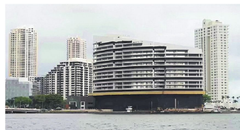
El Hotel Mandarin Oriental que será demolido el domingo.
