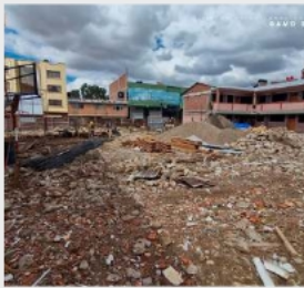
Construcción de la Unidad Educativa José María Sierra Galvarro inició en enero /JSM
