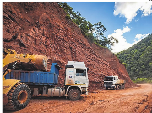
Maquinaria trabaja en la habilitación de distintos tramos
