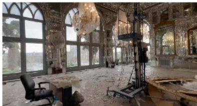
La Unesco ha confirmado que se ha producido daños en el Palacio de Golestán (en la imagen) en Teherán/ EFE / MOMI NEWS
