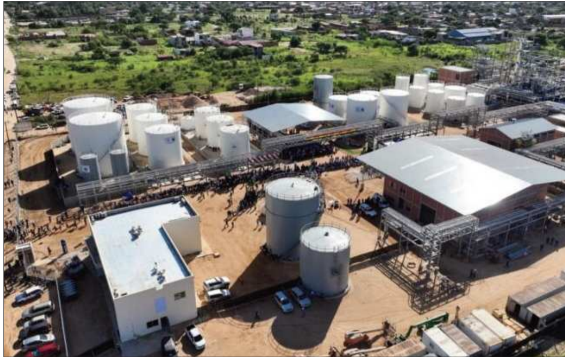
COMPLEJO. Una vista aérea de la planta de biodiésel en Santa Cruz de la Sierra.
