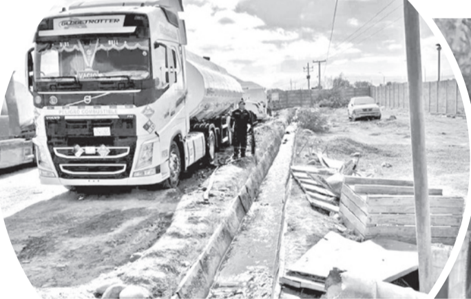
Canales donde se desvía el combustible. A
