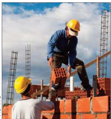
Trabajadores en la construcción.
