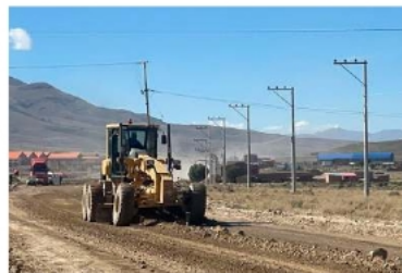
La construcción del Tramo I (Cruce Vinto - Huanuni) ya registra un 31% de ejecución /MBC
