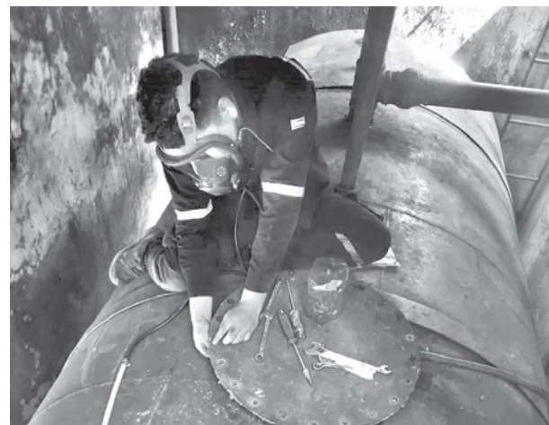
La limpieza de los tanques de YPFB. YPFB
