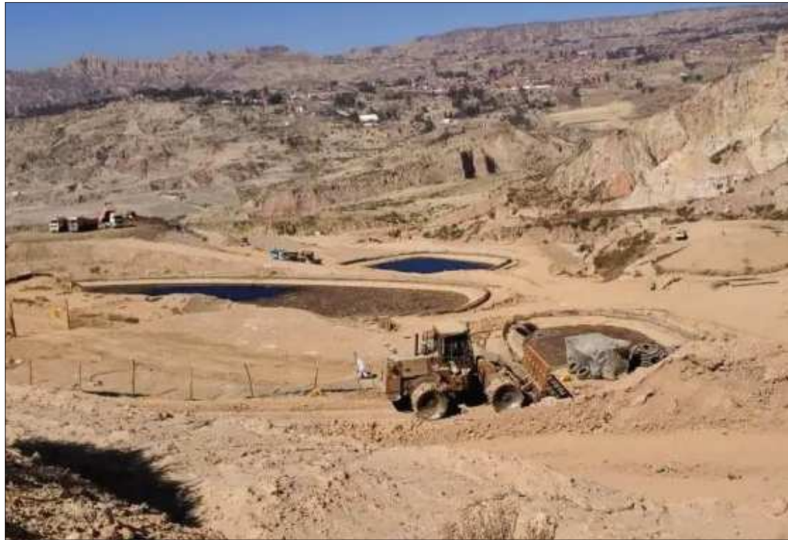
REMOCIÓN. Un tractor realizar trabajo en el relleno de Sak'a Churu, ubicado en Alpacoma.
