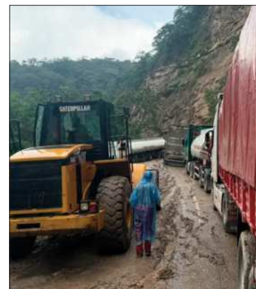
Un tramo carretero afectado
