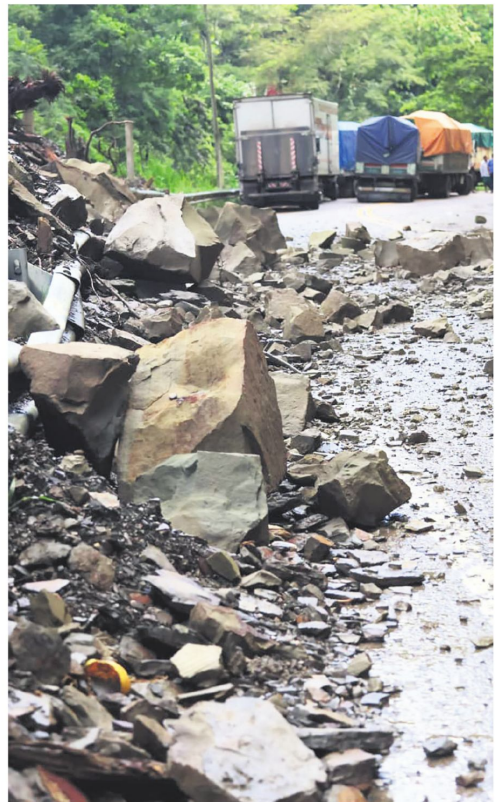
Rocas desprendidas de las montañas afectaron la ruta a Samaipata.
