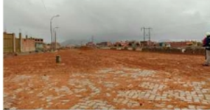
Construcción de la avenida de la Diablada en su segunda fase /GAMO
