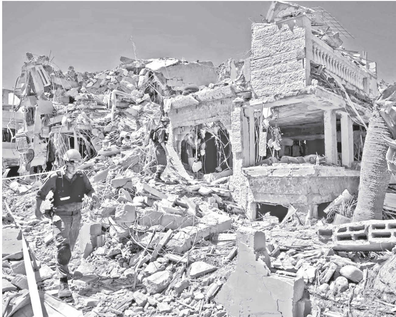
Edificio destruido por los ataques de Irán en Rishon Letzion, al sur de Tel Aviv. EL PAÍS
