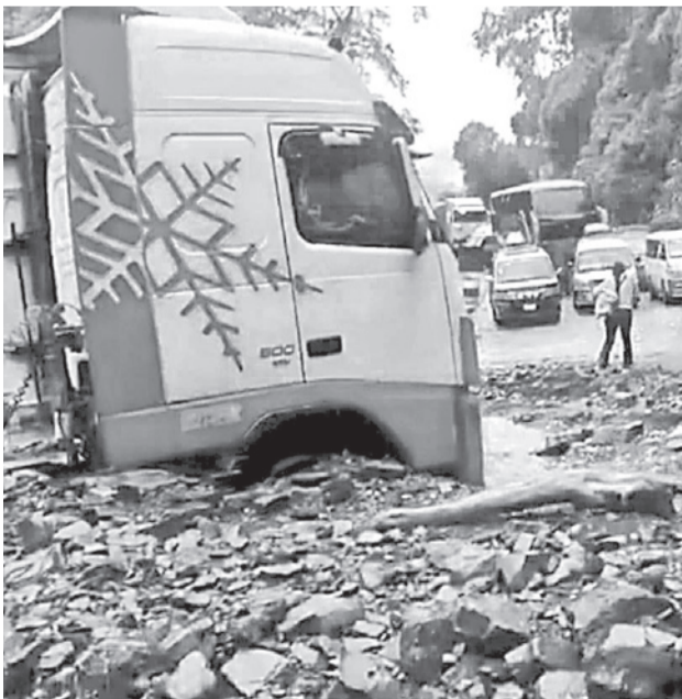
Vehículos afectados por los derrumbes en Siete Curvas. RKC
