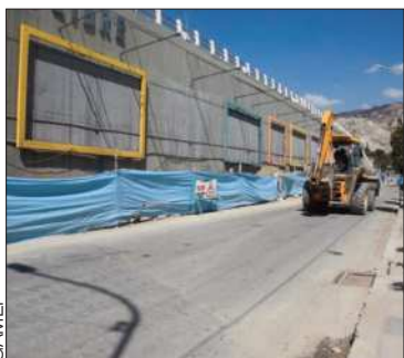
Trabajos en la avenida Costanera.
