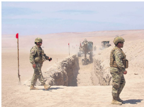
La obras fueron iniciadas la anterior semana
