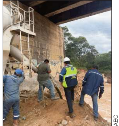
ABC arregla un puente en Abapó
