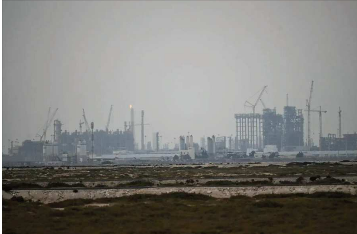
INFRAESTRUCTURA. Instalaciones operativas de QatarEnergy en la ciudad de Ras Laffan, Qatar.
