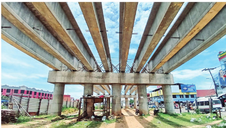
Los vecinos reclaman por la obra inconclusa del viaducto. Piden que retomen los trabajos de construcción
