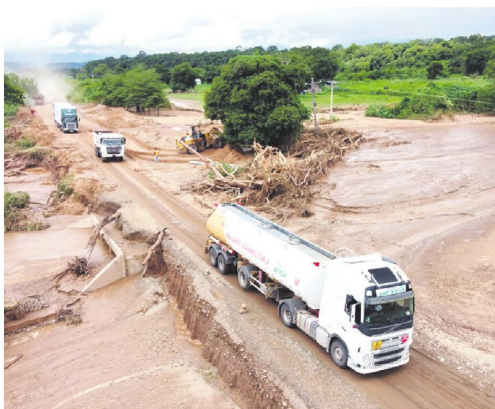
Se habilitó el paso por la carretera en el tramo Abapó-Cabezas
