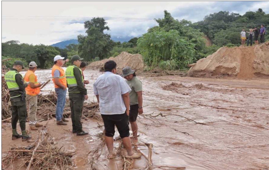
REBALSE. El desborde del río Guapay en el municipio de Abapó dejó intransitable varias vías.
