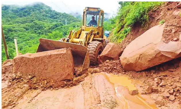
Realizan trabajos de limpieza por derrumbes en el tramo El Salto-Monteagudo
