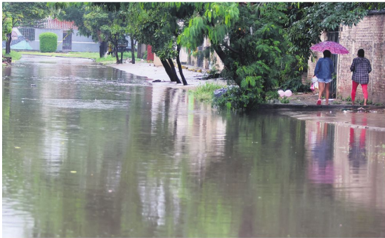
Una de las calles anegadas en el sector norte, entre las radiales 26 y 27
