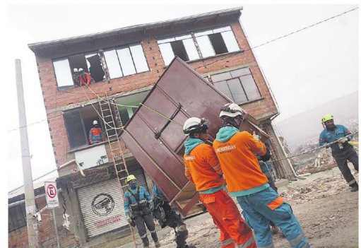
En la ciudad de La Paz evacuaron a familias por riesgo de deslizamientos
