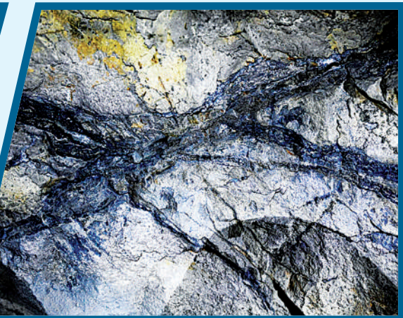
PELIGRO. Los mineros trabajan en medio de rocas.
