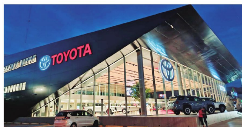
El Showroom destaca por su transparencia y cubierta en pendiente.
