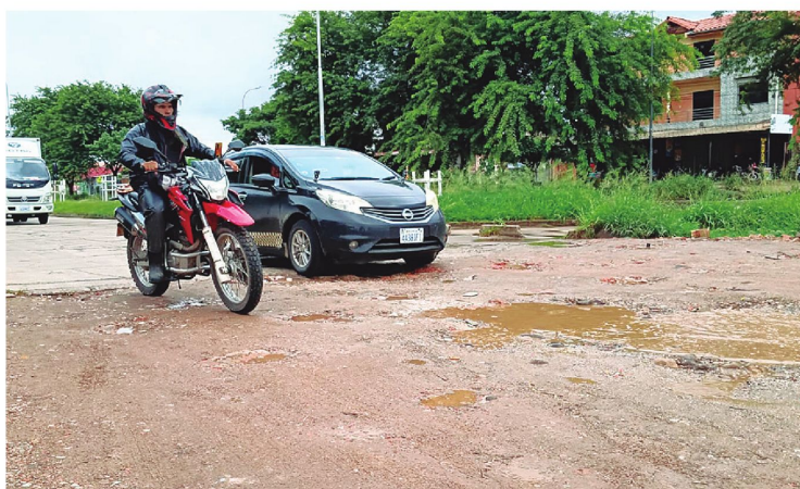
El tramo inconcluso en la avenida 30 de Octubre, que es un dolor de cabeza para los vecinos
