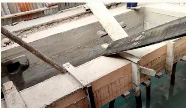
La Unidad de Drenaje Urbano realizó una intervención en el sistema de alcantarillado pluvial /GAMIO
