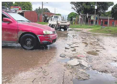
En la avenida 10 de Octubre unieron con losetas el pavimento
