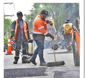
Los trabajos de bacheo en la ciudad. CARLOS LÓPEZ
