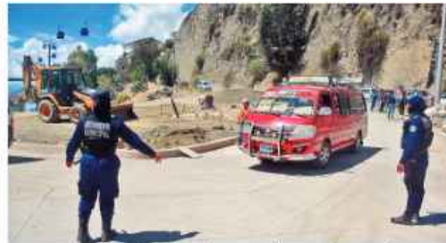
OBRAL. Los vehículos ya podrán circular por la rotonda.
