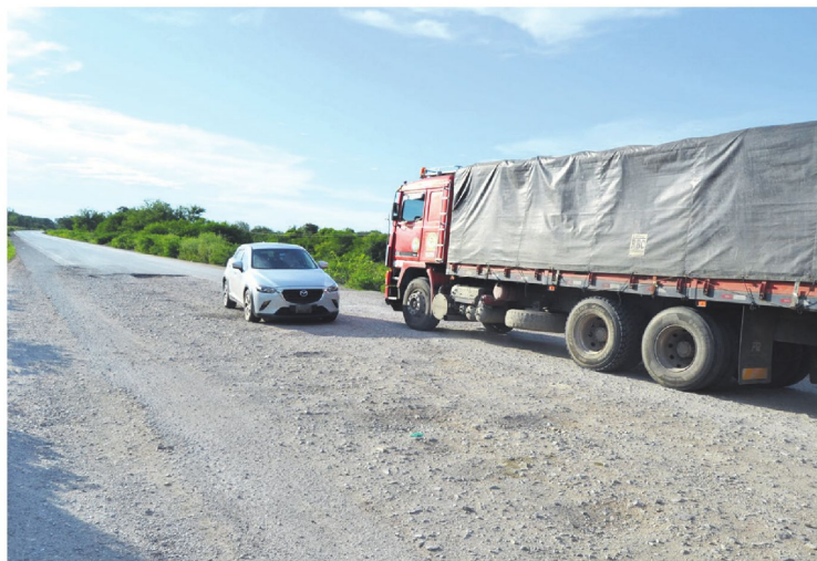
Un camión reduce la velocidad para esquivar los profundos baches en un tramo deteriorado de la carretera
