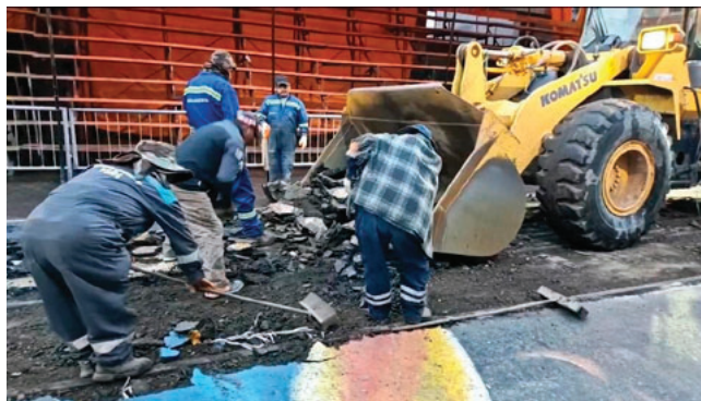
Retiro de la capa asfáltica de las vías del tren tras el Carnaval /GAMO
