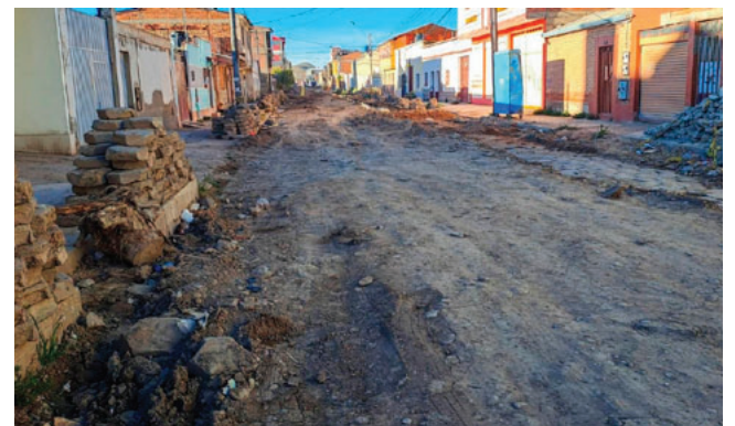
Construcción de Sistema de Alcantarillado Sanitario y Pluvial Junta Vecinal Madrid Integrada avanza /GAMO
