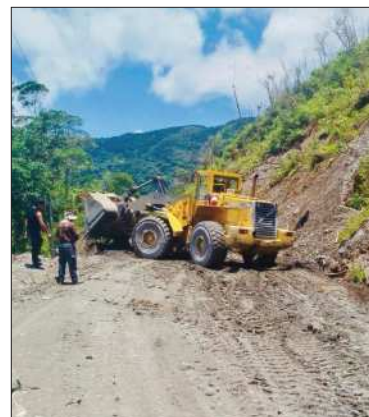
Reparaciones en una carretera.
