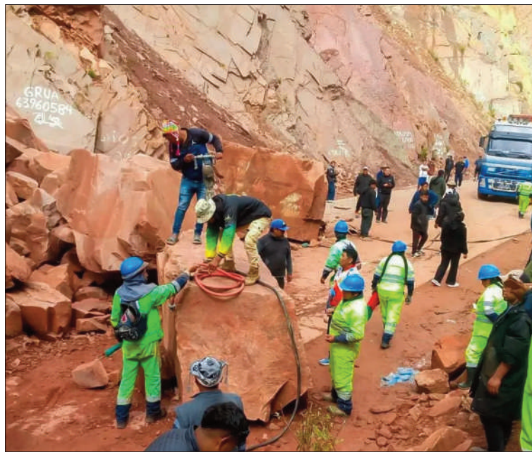
REFACCIÓN. Trabajadores en labores para rehabilitar la vía.
