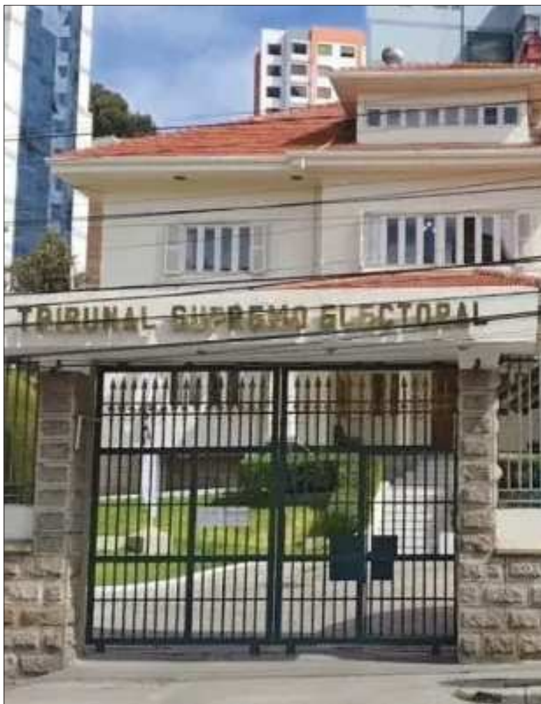
SEDE. Instalaciones del TSE, ubicada en la ciudad de La Paz.
