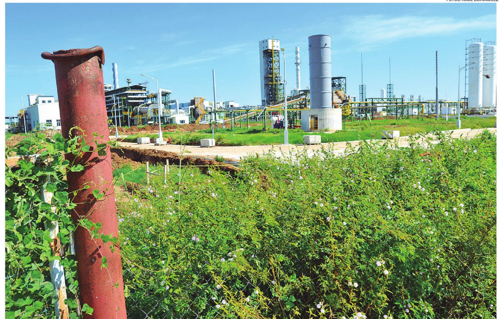
La planta de la ESM está ubicada a 25 kilómetros al sur de la ciudad de Puerto Suárez y se encuentra inoperable. Está invadida por la maleza
