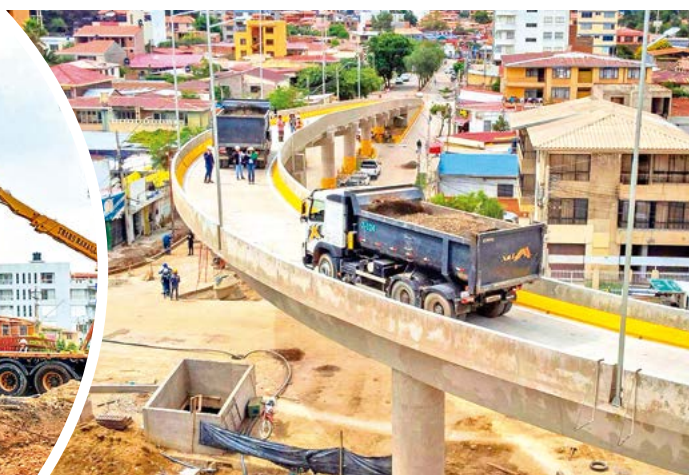
Las pruebas de carga en el nivel aéreo. GAMC
