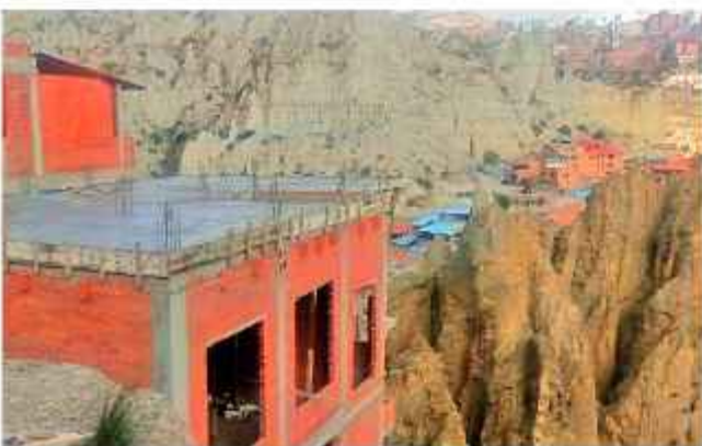
VIVIENDA. La construcción tiene la tercera losa acabada.
