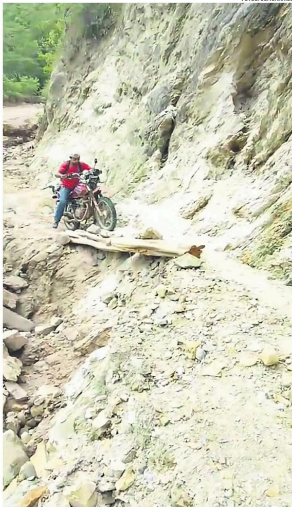
En algunos sectores, los derrumbes se llevaron parte de la plataforma
