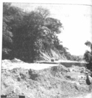
Aquí se construirá un puente.
