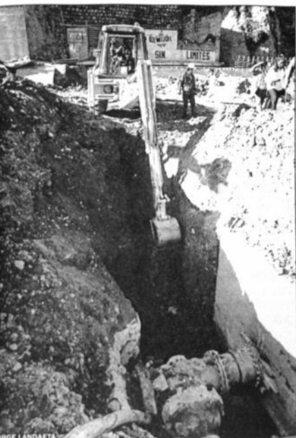
Trabajos en Nudo Vita para reparar cañería.
