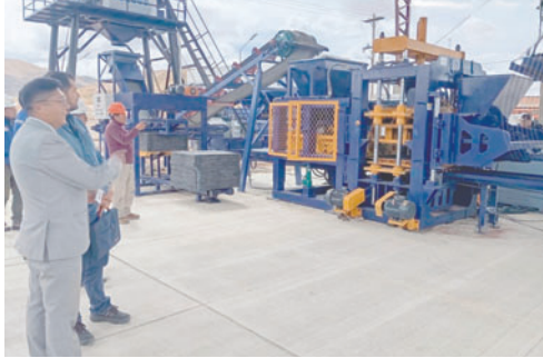
Alcalde inspeccionó la planta de losetas antes de su entrega definitiva /GAMO
