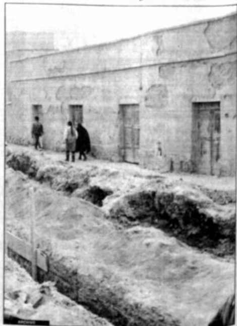
Cavado para poner tuberías.
