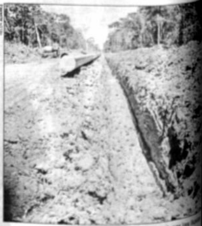
La zanja estaba concluida, pero se derrumbó por las lluvias.
