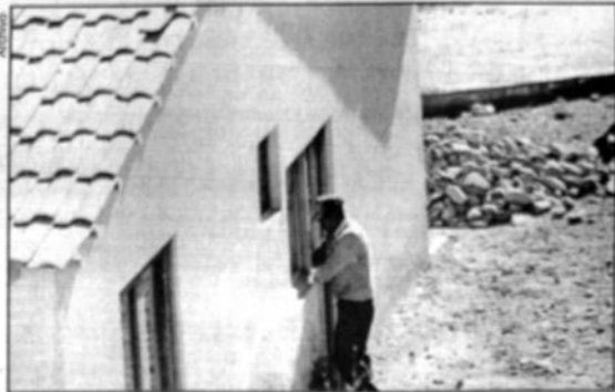
Casa en construcción.
