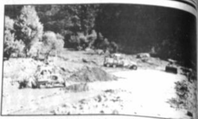
Con la plata construirán gaviones y defensas.
